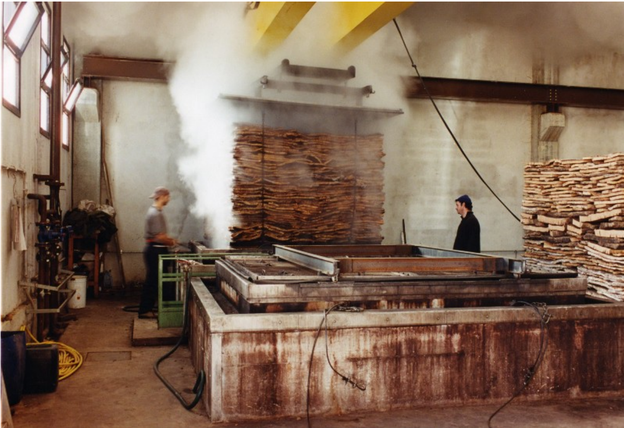
Vasca in acciaio inox per la bollitura del sughero completa di carro ponte
