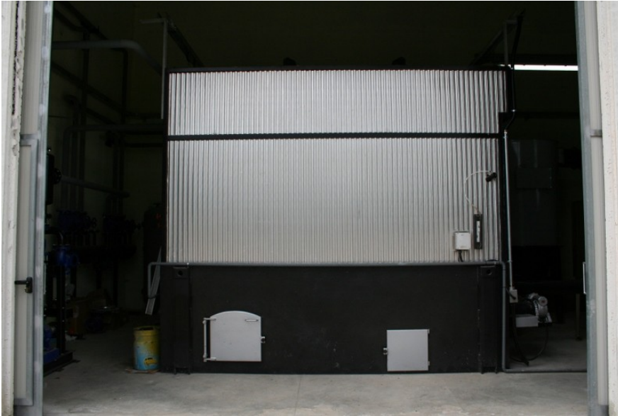
Caldaia alimentata a polverino di sughero
