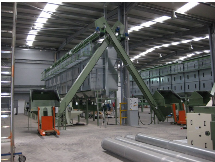
Contenitori per accumulo tappi e rondelle con carico e scarico tramite nastri trasportatori con tappeto in gomma
