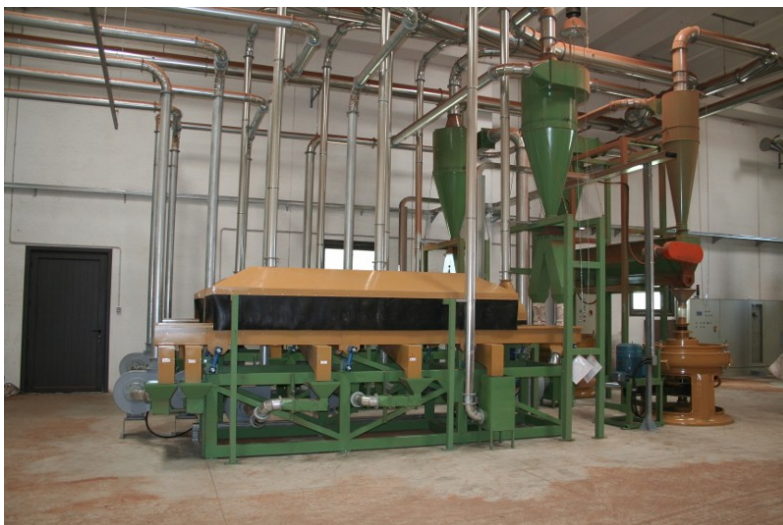
Impianto aspirazione polveri di lavorazione
