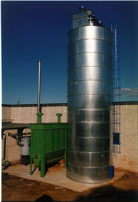
Silo di accumulo polvere con Batteria Filtrante
